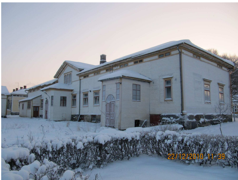
Bild 3. Byggnadens norra sida.
