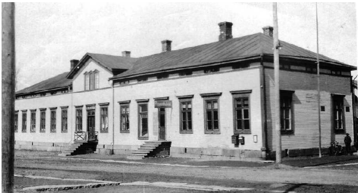
Bild. 2 Byggnadens södra långsida runt år 1918. Byggnaden har här två ingångar från gatan.
